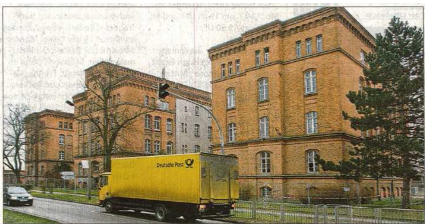
Abbildung 241: Kasernenbauten Neukrugerstraße 65 bis 67 kurz vor dem Abbruch
