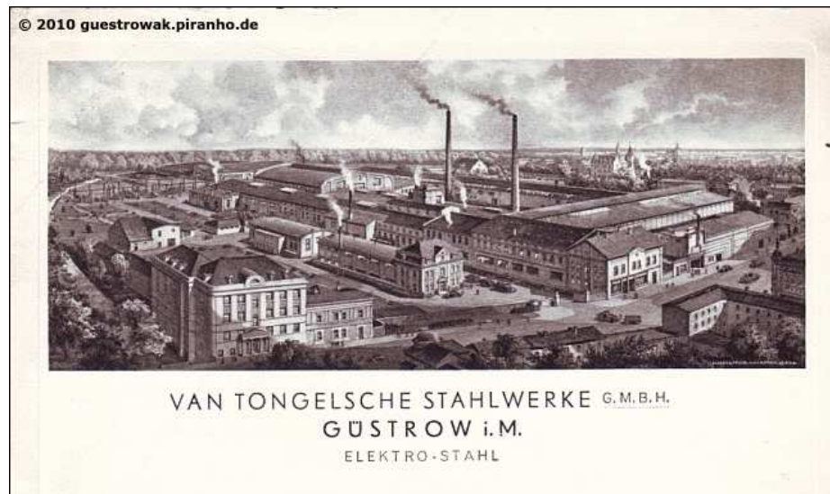
Abbildung 282: Van Tongelsche Stahlwerke
