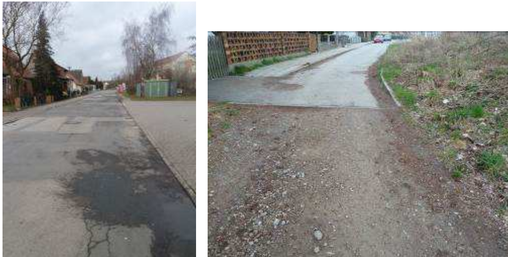
Abbildung 258: Erschließungsanlagen in den Einfamilienhausgebieten rund um den Bärstämmweg
