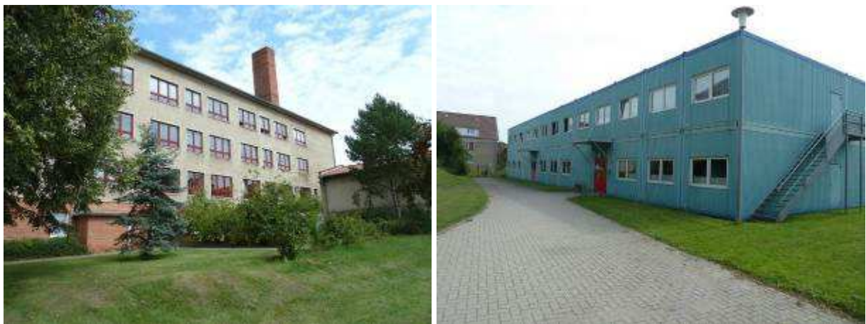
Abbildung 248: unsanierte Regionalschule Thomas Müntzer und Schulcontainer
