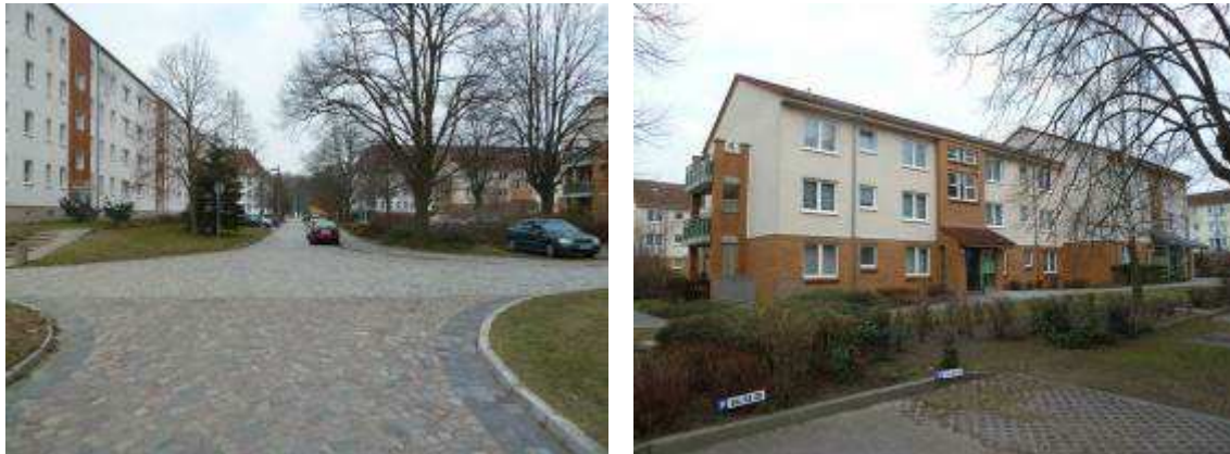
Abbildung 245: Plattenbauten und Neubauten an der Kessiner Straße
