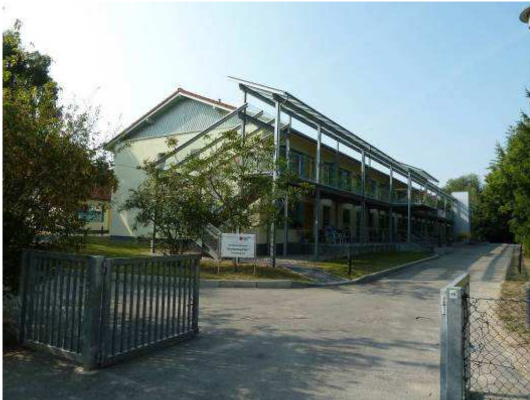
Abbildung 268: Umbau ehemalige Schule in altersgerechte Wohnungen im Tolstoiweg
