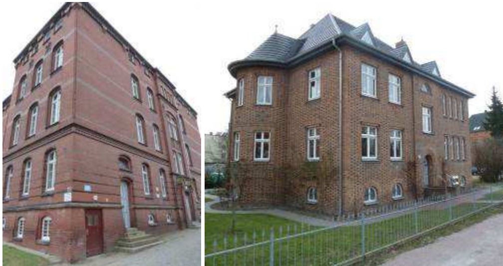
Abbildung 242: Kasernenbauten an der Neukruger- Straße
